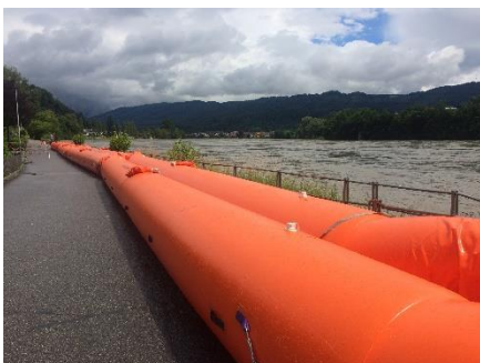
Das Beaver-Hochwasserschutz-System wurde aufgebaut,
